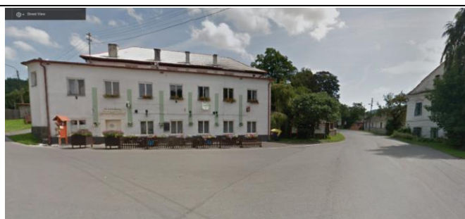
Veřejné prostranství před restaurací "Na rozcestí" s navazujícím fojtstvím
